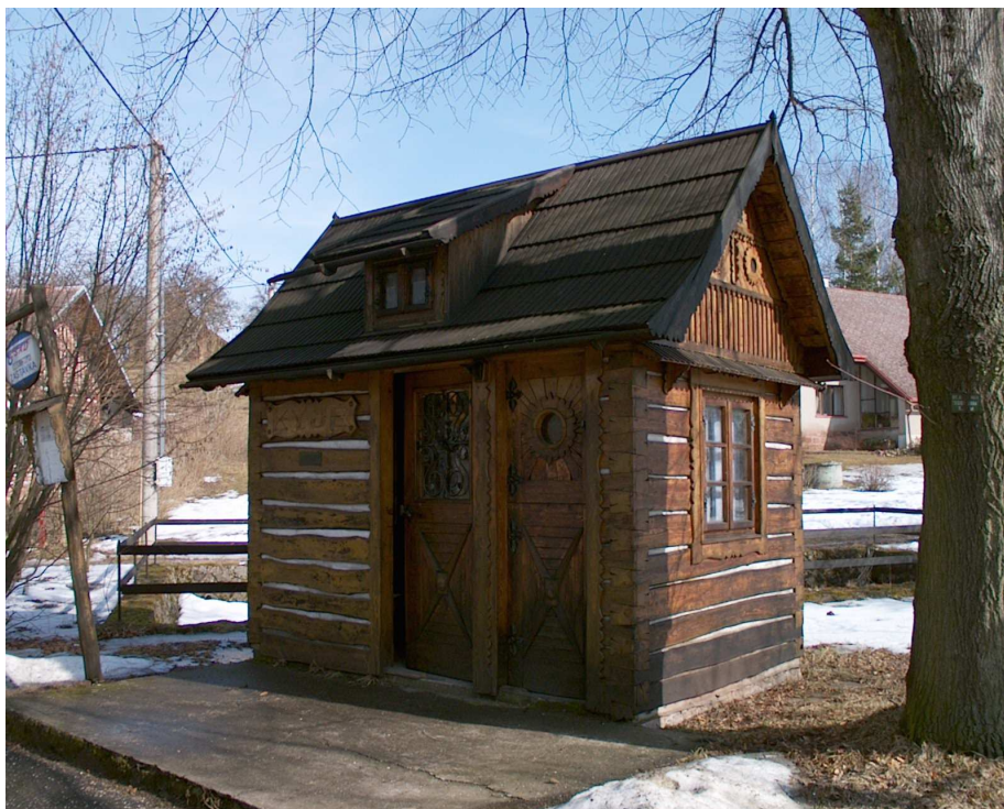
Autobusová čekárna na Kyjích. Nápis na kovovém štítku hlásá: Rodákům a občanům naší vesničky, dar svépomoci maličký, k ochraně ji každý měj, toto dílo naší více v lásce zachovej, L.P. 1973, B.P. (Foto autor – březen 2003)
